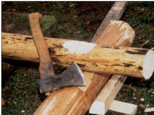
Beim Absägen der Stangen in der Nähe der Verbindungsstellen ist darauf zu achten, dass das Holz weit genug übersteht, damit es nicht aufreißt. Je nach Größe und Art des Verbindungsmittels ist der Randabstand zu wählen. Bei einem Nagel 42/110 beträgt der Randabstand mindestens 50 mm, bei einem Bolzen M 12 mindestens 250 mm.
