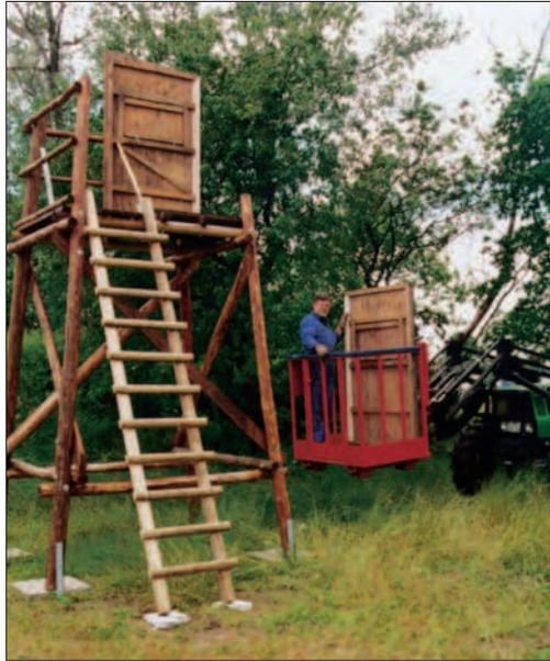
– Beim Aufstellen von Hochsitzen sind Schlepper, mit an dem Frontlader angebaute Arbeitsplattform, sehr hilfreich. In der Plattform hat man einen sicheren Arbeitsplatz und man kann Baumaterial bequem nach oben transportieren.
