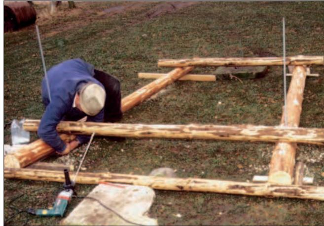
Die Verbindung der Hölzer erfolgt durch Verbolzen. Es werden Gewindestangen M 12, Bulldogdübel ( 50 mm und U - Scheiben 58/6 mm) verwendet. Die Gewindestangen werden durch die Bohrungen gesteckt und dann passend abgesägt. Die Bulldogdübel zwischen den Hölzern und die großen Unterlegscheiben unter den Muttern gewährleisten eine feste Verbindung. Werden frisch geschlagene Stangen verwendet, müssen die Schrauben nach dem Abtrocknen nachgezogen werden.
