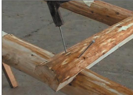
*Werden die Sprossen mit Nägeln befestigt, sind diese versetzt und schwalbenschwanzförmig einzuschlagen. Der Sprossenüberstand beträgt 5 cm, damit das Holz nicht aufreißt.*
