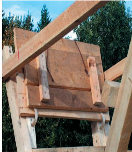
15. Um eine große Durchstiegsöffnung zu erreichen, muss das Sitzbrett möglichst hoch geklappt werden können. Dazu unterhalb des vorderen Sitzbrettes mittig einen kleinen Nagel einschlagen. Durch den Schlüsselring ein Stück Band ziehen und umgeschlagen. Das Band auf der Rückseite der Rückenlehne so anbringen, dass der Schlüsselring gerade noch über den Nagel (unter dem Sitzbrett) gehakt werden kann.
