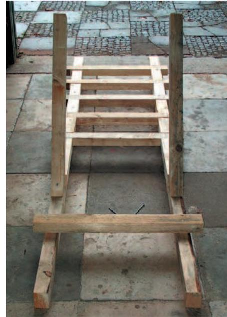
7. Die Aufstiegsleiter durch eine zweite Person aufrichten oder anlehnen (z.B. an einen Baum).
