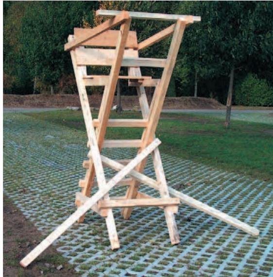
Diese kleine Ansitzleiter aus Schnittholz kann im Revier universell eingesetzt werden. Der Zuschnitt der Hölzer wird mit einer Kapp- und Gehrungssäge durchgeführt. Bei Bedarf kann man in kurzer Zeit den Zuschnitt für mehrere Leitern erledigen.
