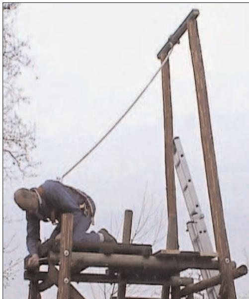
– Diese erhöhten Anschlagpunkte sind ideal zum Einhängen des Sicherheitsgeschirres. Der Sicherheitsgurt mit geeignetem Falldämpfer verhindert den Absturz der Person, die oben arbeitet.
