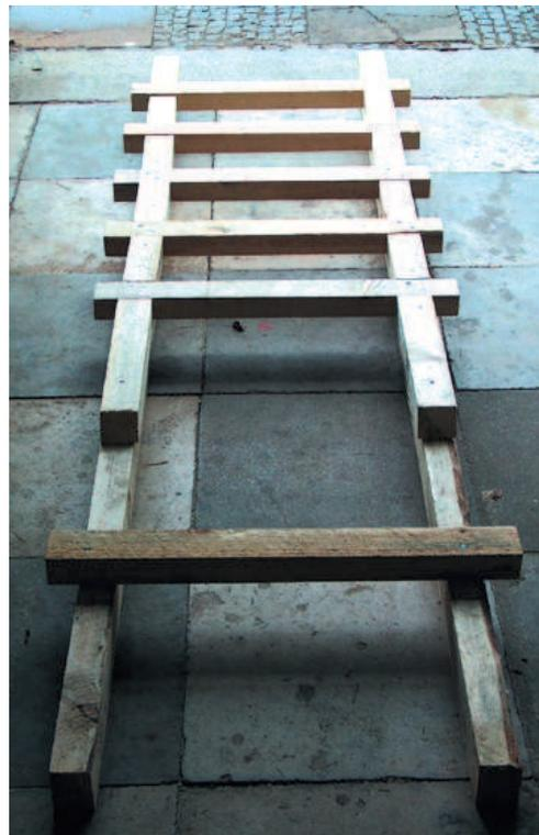
5. Die unterste Sprosse (Nr. 7) mit je zwei Nägeln pro Holm aufnageln. Der Sprossenüberstand beträgt 5 cm auf jeder Holmseite. Damit die Holme beim Zusammenbau parallel liegen bleiben, wird die sechste Sprosse ca. 50 cm unterhalb der oberen Holmenden aufgenagelt. Dann die Distanzhölzer und Sprossen im Wechsel befestigen.
