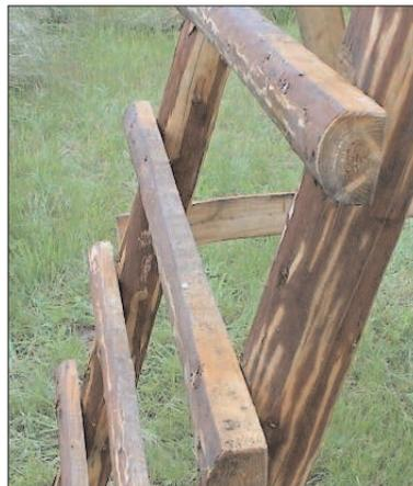
Oft werden Halbrundsprossen (Halblinge) verwendet. Die auf der Kreissäge aufgetrennten Stangen haben als Sprossen nur eine kleine Auftrittsfläche, von der man sehr leicht abrutschen kann. Es hat sich bewährt, diesen Grat mit der Kreissäge abzutrennen, so dass eine ca. 30 mm breite Auftrittsfläche entsteht.
