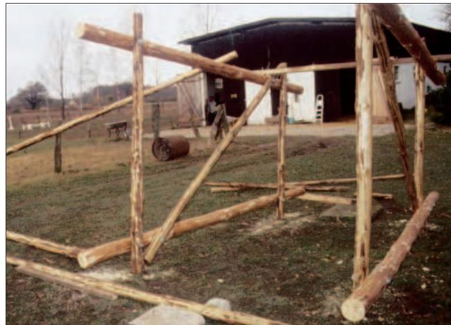
Nachdem 2 Seitenteile fertig montiert sind, werden sie seitlich aufgerichtet und mit Latten abgestützt. Mit Hilfe der rechtwinklig gespannten Schnur werden auch diese Seitenteile ausgerichtet, so dass alle 4 Seiten des Bockgerüsts die gleiche Neigung haben. Dann können die Quer- und Diagonalstreben montiert werden. Bei Bockgerüsten mit 7 m Podesthöhe kann es Probleme beim Transport
